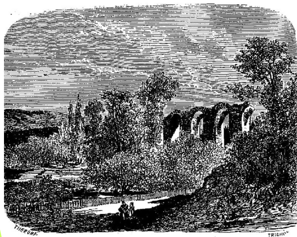
Aqueduc de Maintenon.
